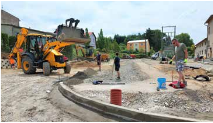
Práce na parkovišti u sokolovny finišují, na snímku vlevo se zakládají obrubníky a vpravo pracují obecní zaměstnanci na zateplení fasády sokolovny. Foto: Přemysl Tonar
