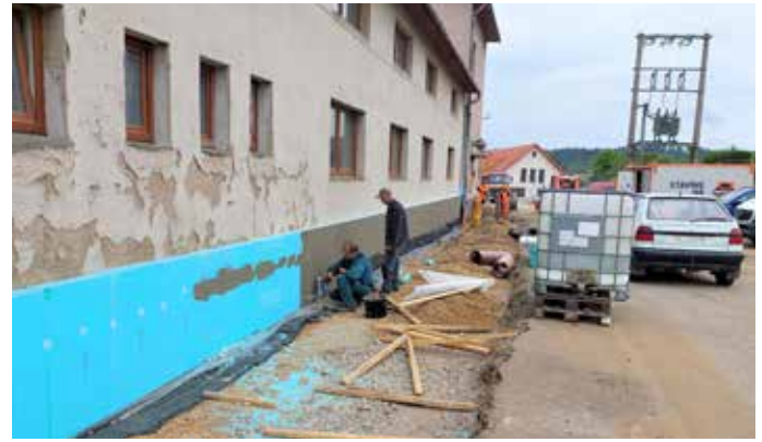
Práce na parkovišti u sokolovny finišují, na snímku vlevo se zakládají obrubníky a vpravo pracují obecní zaměstnanci na zateplení fasády sokolovny. Foto: Přemysl Tonar
