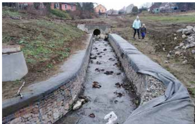
Gabionové opevnění potoka u Janáčků, které chrání nově vybudovanou splaškovou kanalizaci. Foto: Hana Tonarová
