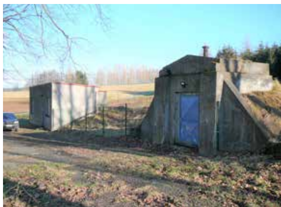
Městys využívá tři vodárenské budovy, a z toho dvě by si zasloužily kompletní modernizaci. Foto: Hana Tonarová
