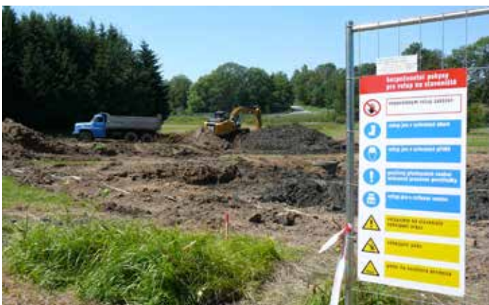
Výstavba začala bagrováním místa, kde bude stát budova ČOV s nádržemi. Foto: Hana Tonarová
