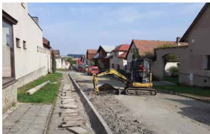
Zeleného ulice dostala v září nové obrubníky a v říjnu ji čeká i povrch. Foto: Přemysl Tonar
