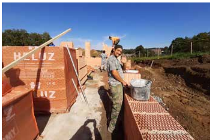
Výstavba přízemí mateřské školy finišuje. Foto: Martina Brychtová
