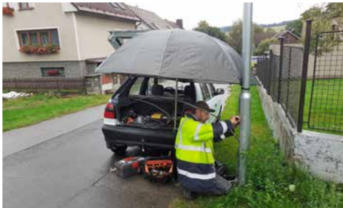
Zapojení části nového veřejného osvětlení. Foto: Přemysl Tonar
