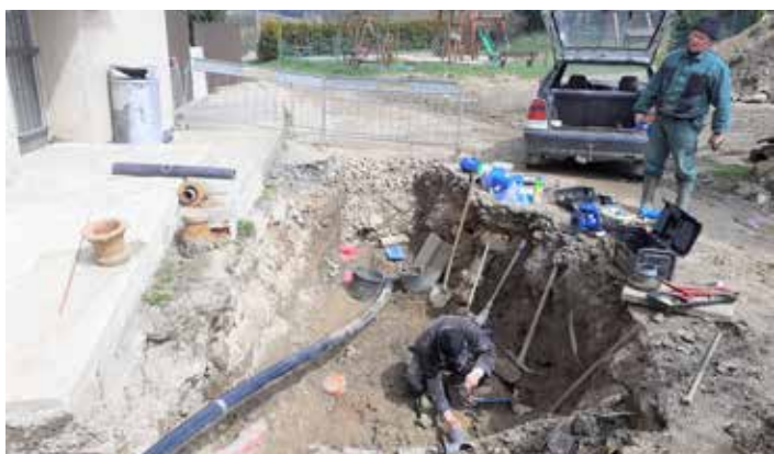
Výměna armatur a hydrantu na vodovodním řádu u sokolovny. Foto: Přemysl Tonar
