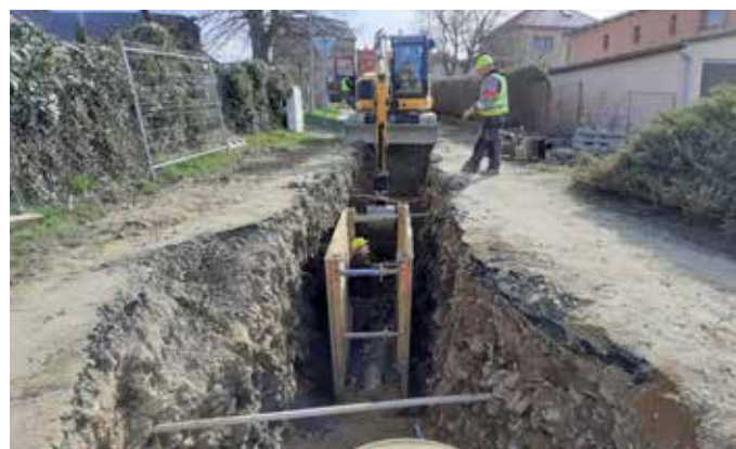
Práce na kanalizaci pokračují v ulici Horní Obec pod Moštárnou. Foto: Přemysl Tonar
