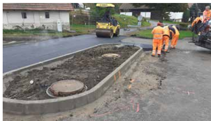
Krajská správa a údržba silnic dokončila v říjnu v Peršíkově opravu mostku. Foto: Přemysl Tonar
