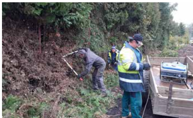
Před zahájením prací na novém dětské hřišti u sokolovny bylo potřeba odstranit tují kolem plotu. Foto: Přemysl Tonar
