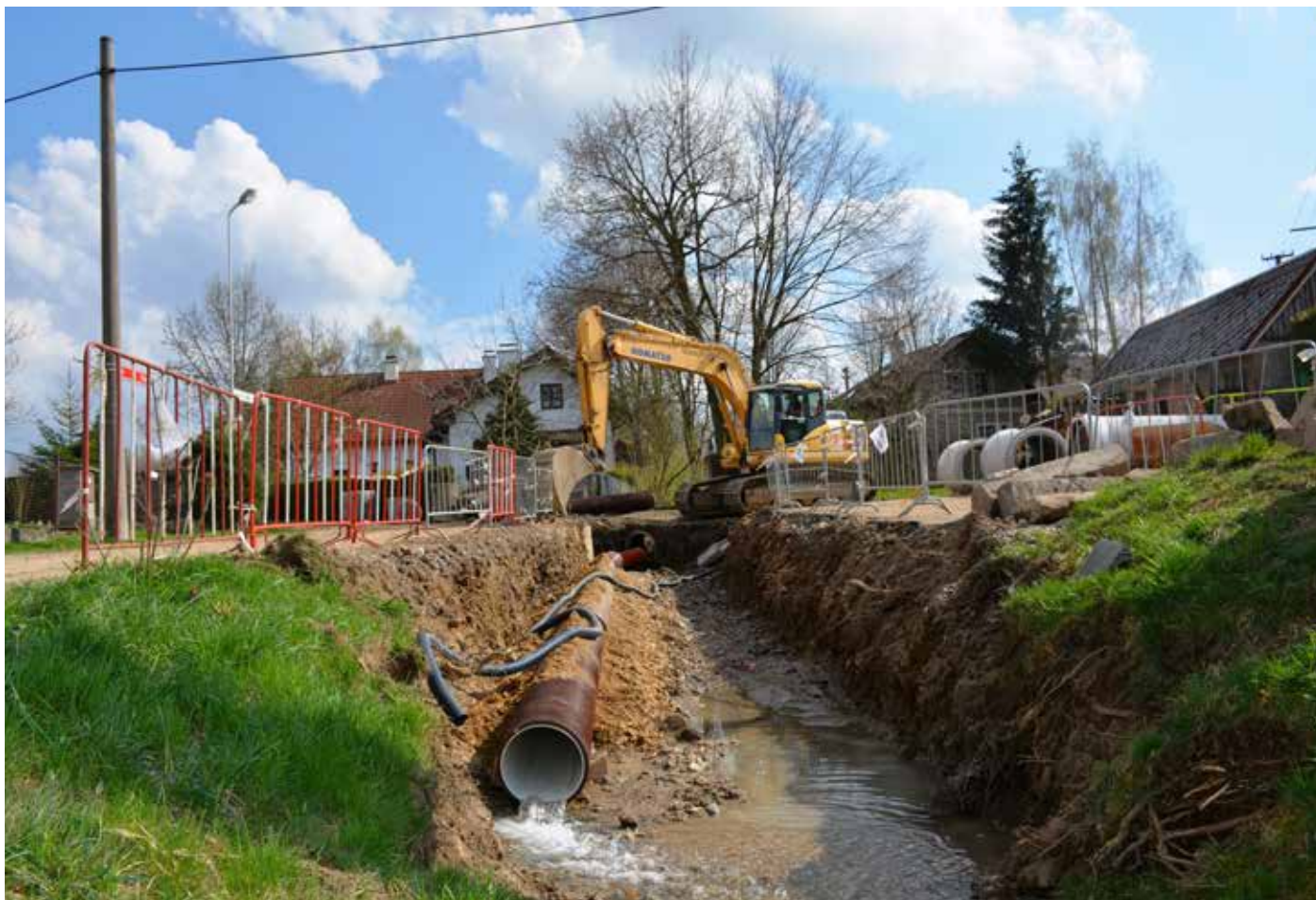
Rekonstrukce propustku na křižovatce ulice Horní obec a Polní z důvodu havarijního stavu započala druhou dubnovou středou. Foto: Linda Burianová
