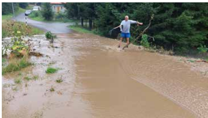
Opoledne 16. srpna zasáhla obec silná bouřka. Vyplaveny byly sklepy u rodinných domů a některé propustky nestíhaly provést velké množství vody. Na fotce je propustek u nové ČOV. Foto: Přemysl Tonar
