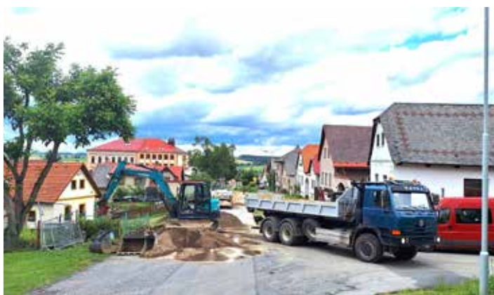
Oprava dešťové kanalizace v ulici K Vepřové by měla být do konce srpna hotová. Foto: Přemysl Tonar
