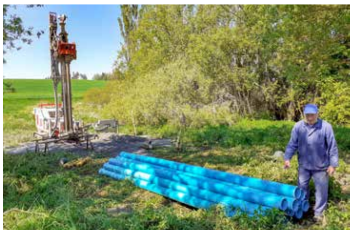
Na vrtání nového zdroje pitné vody dohlížel mistr přes vodu v obci Karel Krčál. Foto: Přemysl Tonar
