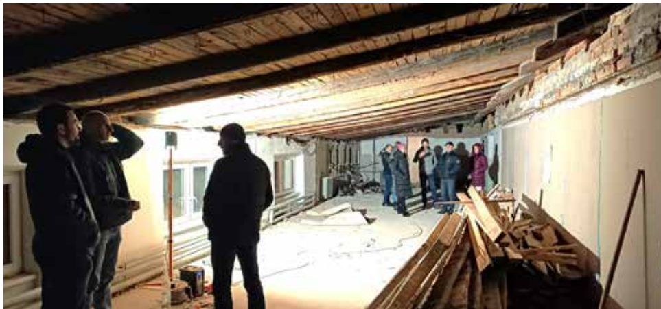
Zastupitelé se po svém lednovém setkání šli podívat do sokolovny, kde probíhá rekonstrukce pravé galerie. Foto: Hana Tonarová
