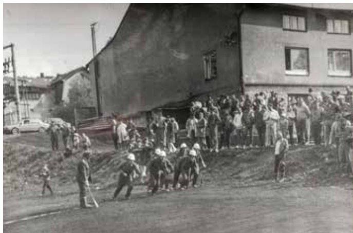
Sokolovna ještě před stavbou přístavby ubytovny kolem roku 1985. Archiv Petra Kučery
