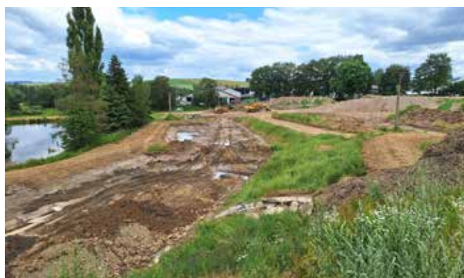
Začala sanace staré kořenové čistírny pod sběrným dvorem. Foto: Přemysl Tonar
