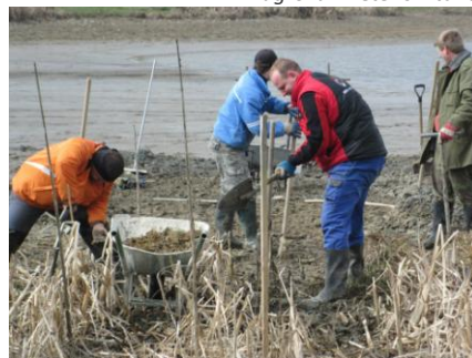
Příprava na betonování mola
