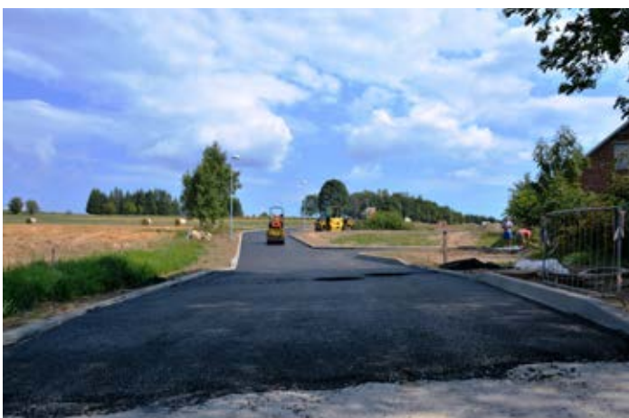
Pokládání asfaltového povrchu v ulici Polní. Foto: Linda Burianová
