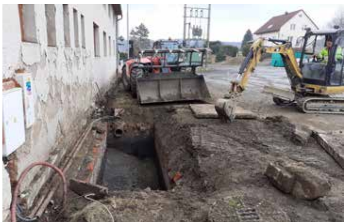
Při odkopání sokolovny došlo zároveň ke zrušení septiku a propojení sokolovny na stávající kanalizaci. Foto: Přemysl Tonar
