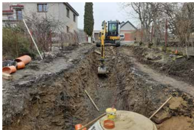
Budování kanalizace postupuje dalšími ulicemi, zde ulice Polní nad vinárnou. Foto: Přemysl Tonar
