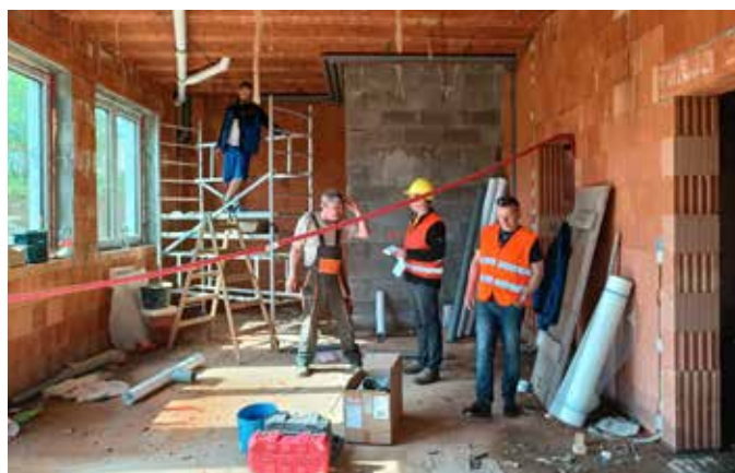
Aktuálně se v nové školce řeší vnitřní rozvody. Foto: Hana Tonarová
