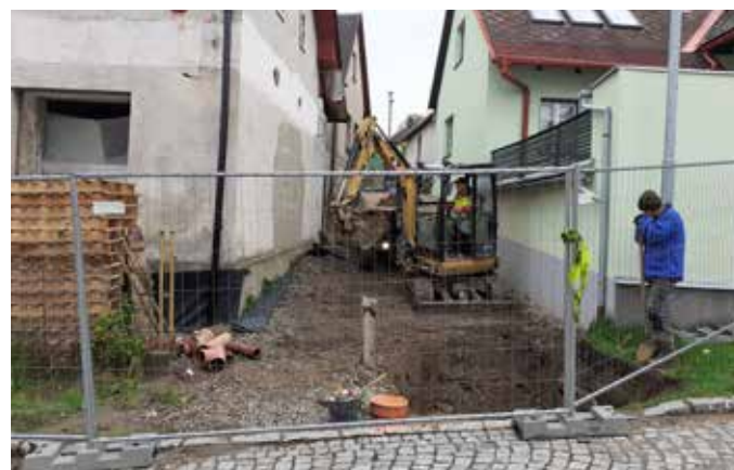
Obnova splaškové a dešťové kanalizace a vodovodu v Havlíčkově ulici. Foto: Přemysl Tonar
