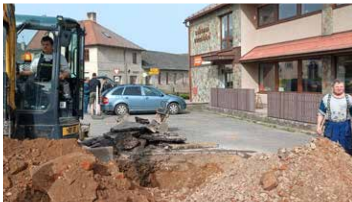
Bagrování před Coopem mělo odhalit, co se skrývá pod povrchem. Sklepy původního stavení Stránských byly znovu lépe zasypany, aby se zabránilo propadům parkoviště. Foto: Hana Tonarová
