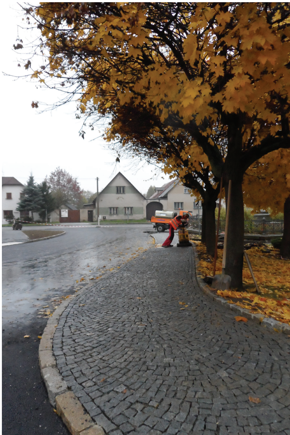
Práce finišují. Silnice K Vepřové po pokládce asfaltového povrchu poslední říjnovou sobotu, pár hodin před sněhovou nadílkou. Foto: Linda Burianová
