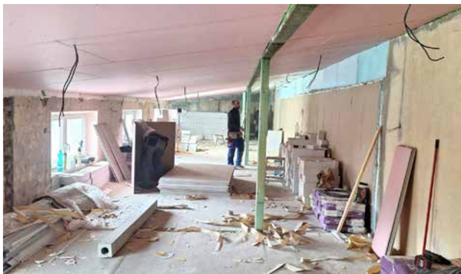
V sokolovně na pravé galerii se v únoru dělal sádkartonový strop a v březnu následuje štuk a obkládání toalet, které nahoře taktéž vzniknou. Foto: Přemysl Tonar
