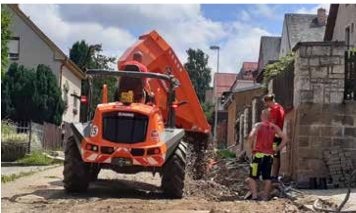
Provádění prací na pokládce nového vodovodního potrubí v ulici Rybízovna. Foto: Přemysl Tonar
