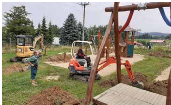
Demontace stávajícího dětského hřiště u sokolovny, které ustoupilo staveništi nové školky. Foto: Přemysl Tonar
