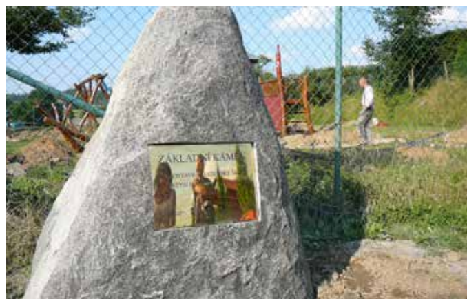
Práce na novostavbě mateřské školy již začaly, prvním počinem bylo odhalení základního kamene. Foto: Hana Tonarová
