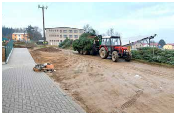
Odstranění smrků a tují u sokolovny bylo nutné kvůli výstavbě komunikace k nové škole. Foto: Přemysl Tonař
