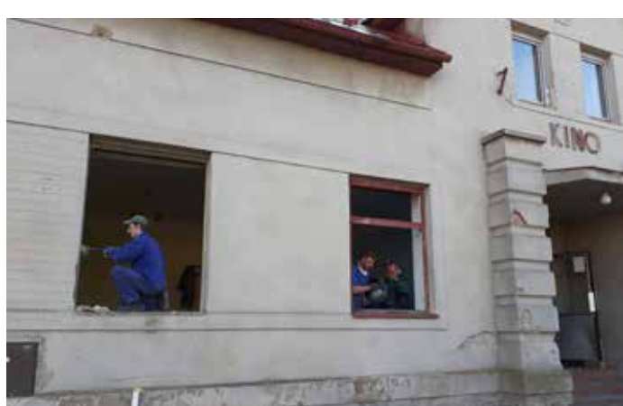
Budova sokolovny se dočkala výměny 84 oken. Foto: Přemysl Tonar
