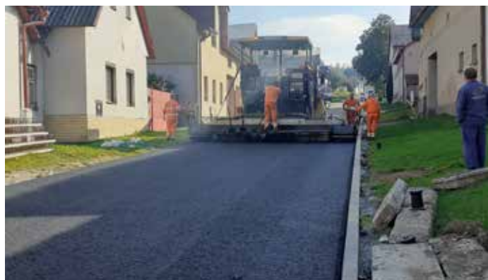
Ačkoli kvůli budování kanalizace vypadaly borovské ulice řadu měsíců jako tankodrom, podařilo se opravit většina ulic plně a nikoli jen záplatováním, jak bylo v projektu. Foto: Přemysl Tonar
