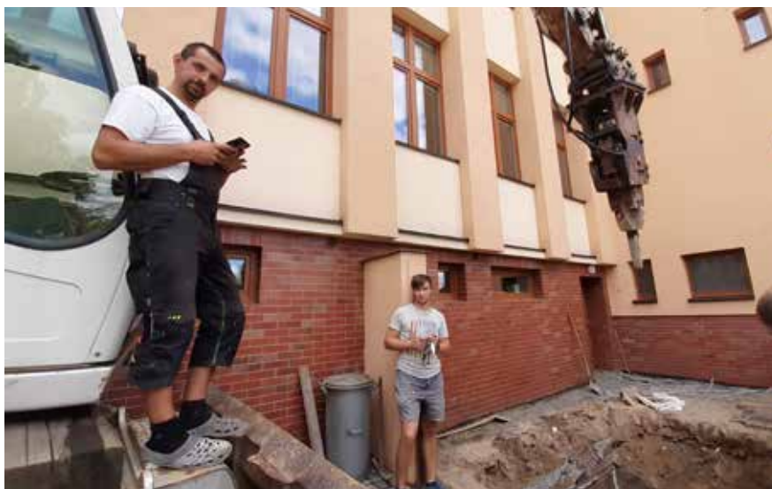
Budova základní školy už je napojená na ČOV. Foto: Martina Brychtová
