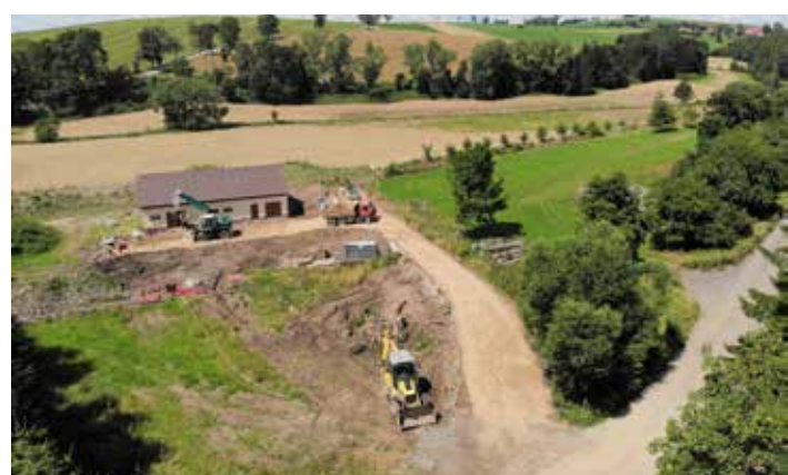
K čistírně odpadních vod byla vybudována přístupová komunikace. Foto: Michal Pavlas
