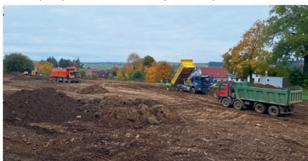
Hřiště u vodárny prochází kompletní úpravou. Foto: Přemysl Tonar
