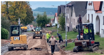
Ulice K Vepřové již dostává žulové obrubníky. Foto: Přemysl Tonar
